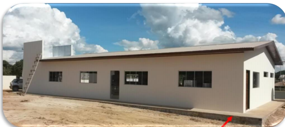
Construção de Centro de Promoção de atividades Econômica e Social em Nova Guarita/MT-2015
