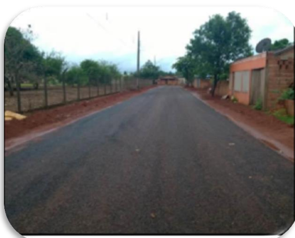
Pavimentação asfáltica urbana – Tangará da Serra/MT-2014
