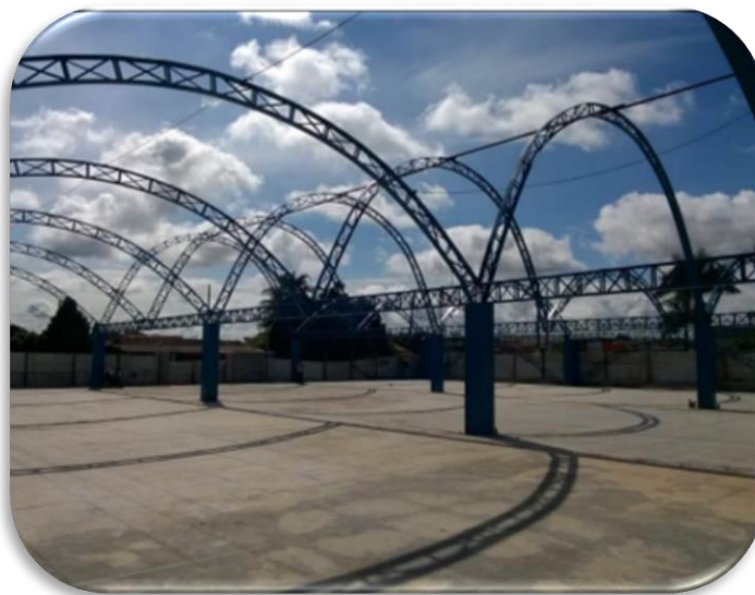
Construção de cobertura para feira-livre – Rondonópolis/MT-2015
