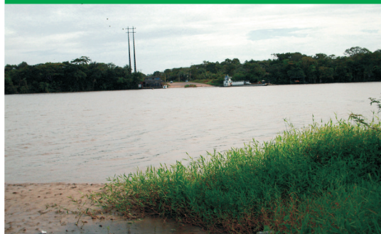
Rio Vila Nova: ponte vai interagir os municípios de Macapá e Mazagão
