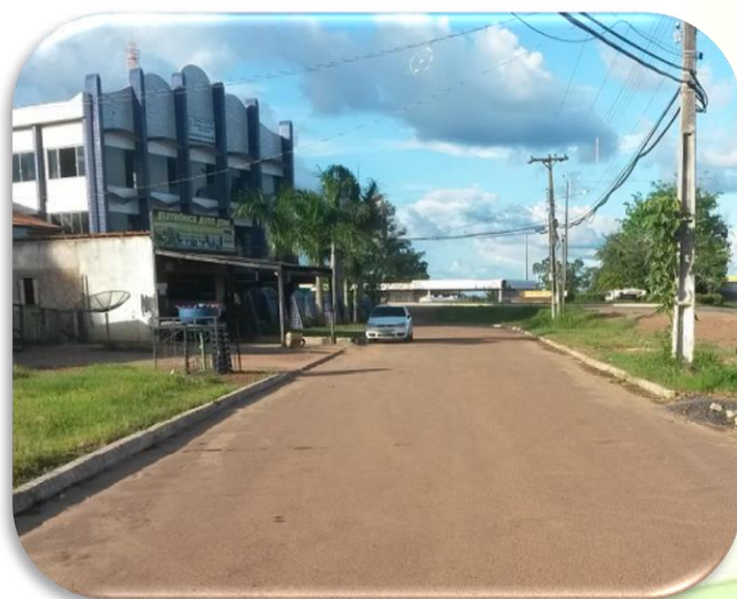
Pavimentação urbana – Marabá/PA, 2016
