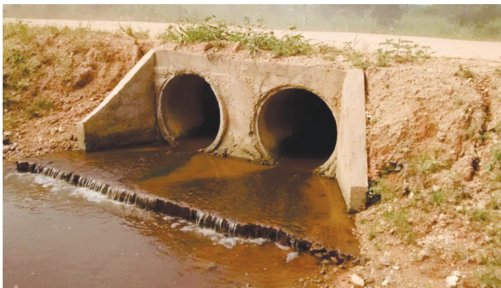
PONTE DE MANILHA E CONCRETO TUCUMÃ-PA
