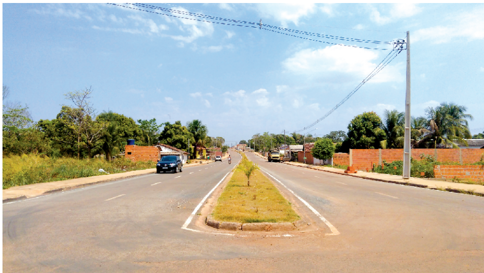
PAVIMENTAÇÃO COM DRENAGEM ALTO PARAGUAI - MT
