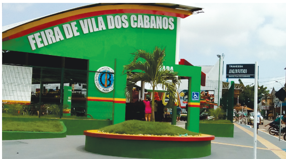
FEIRA COBERTA VILA DOS CABANOS - PA
